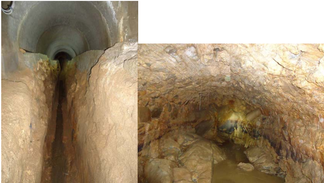
A l'esquerra vista de la mina des del sud, on es pot veure la coberta de formigó de l'any 2001. A la dreta, vista del punt de captació de la mina.
